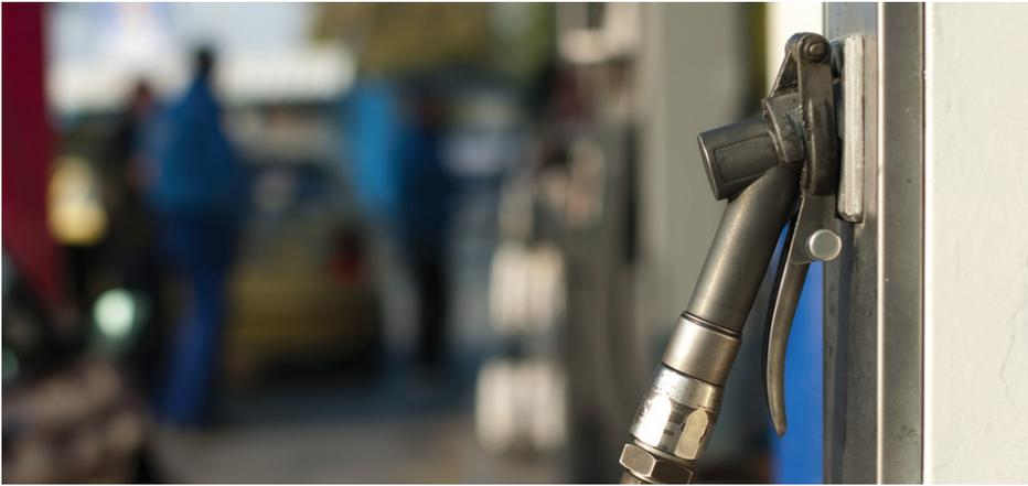
Dans les stations publiques du Canada, le GNC est distribué à une pression stabilisée de 3 000 au pouce carré (lb/p<sup>2</sup>), tandis que dans le cas des stations privées, il est distribué à une pression stabilisée de 3 600 lb/p<sup>2</sup>.
